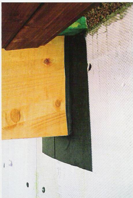
Auch bei Durchdringungen darf die Luftdichtheit nicht vernachlässigt werden. Hier wurden die Fugen zwischen Holzleimbinder und Außenwand mit einem Band abgeklebt.
